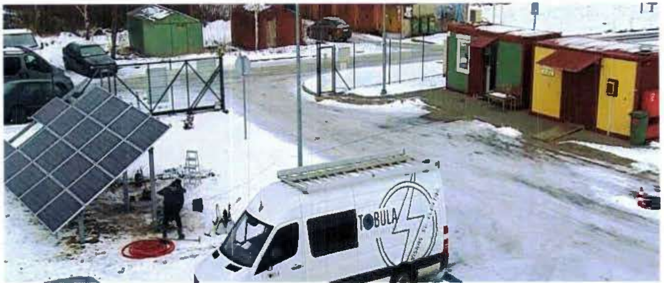
5 pav. Saulės kolektorių įrengimas Šiaurės aikštelėje
