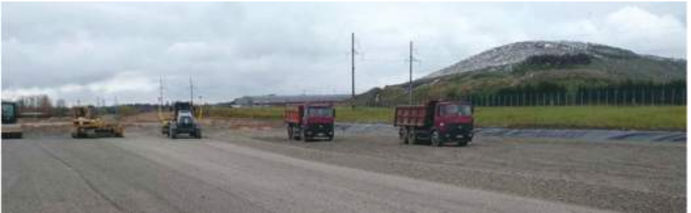
15 pav. Šlako apdorojimo aikštelės (II etapo) įrengimo darbai
